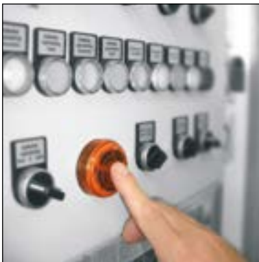
Wyciszenie sygnału poprzez dotknięcie sygnalizatora
